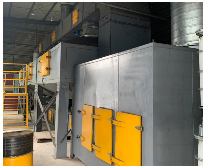
废气处理设施：吸附浓缩—催化净化设备
